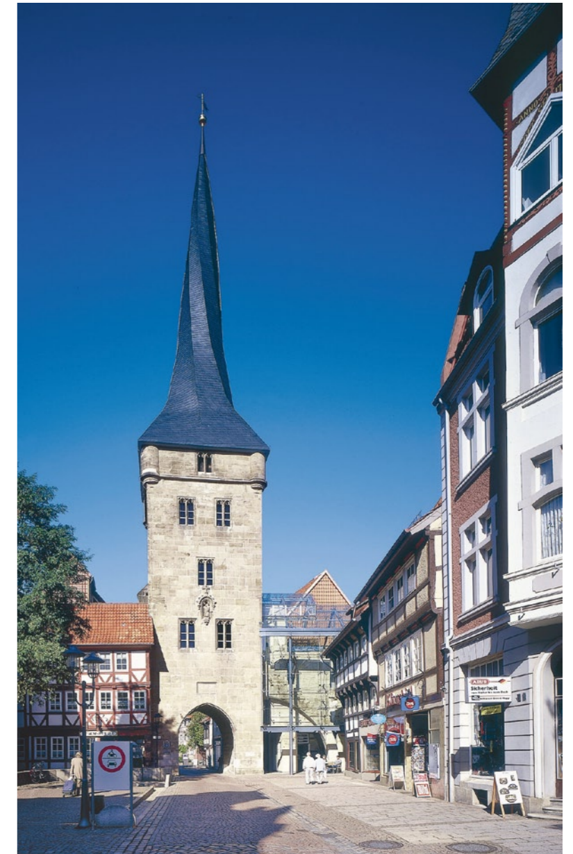
Die nordöstlich an den Turm anschließende Mauerüberbauung wurde durch einen Neubau ersetzt. Die Stahl-Glas-Konstruktion dient zur Einhausung des freigelegten Maueranschlusses und steht im Kontrast zum historischen Stadtbild.
