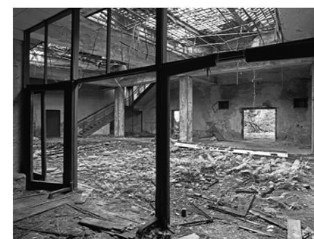
Der Vergleich mit der Situation vor Beginn der Bauarbeiten zeigt, vor welcher Aufgabe die Planer standen: Nach der Zerstörung im Zweiten Weltkrieg war die Ruine jahrzehntelang der Witterung ausgesetzt.
