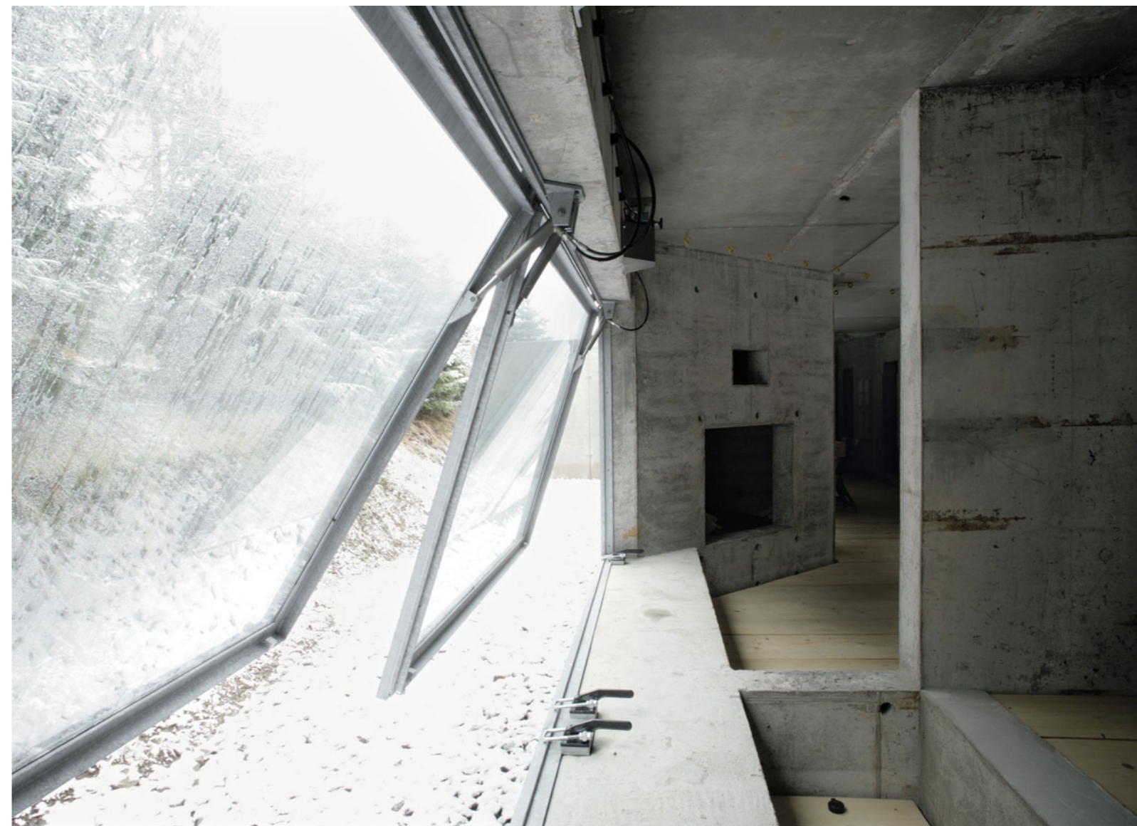
Die beiden großen Fenster zum Wald lassen sich über einen Kippmechanismus weit nach außen schwenken.
