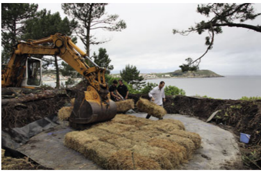
Strohballen auf der ersten Zementschicht
