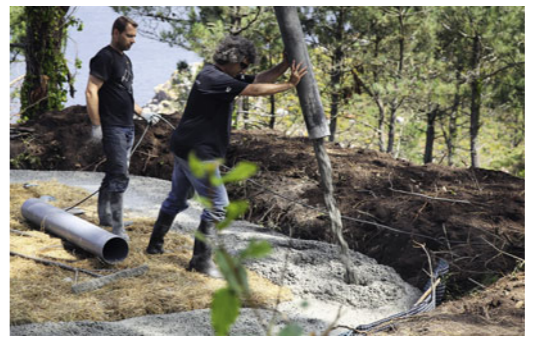
Strohballen für die Aussparung des Innenraums
