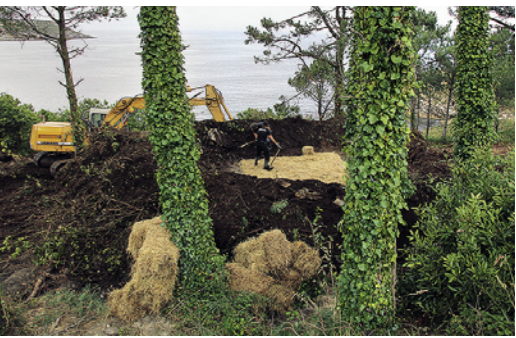
Sukzessives Erhöhen des Erdwalls
