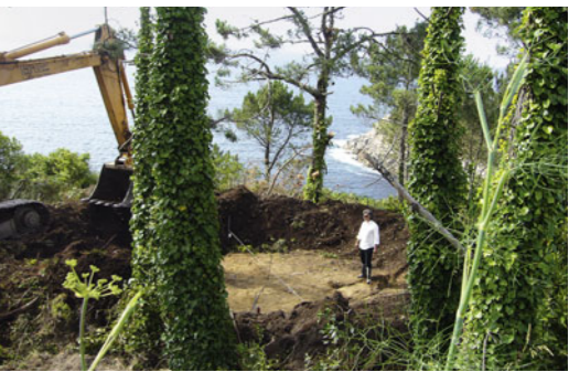
Freiräumen des Bauplatzes
