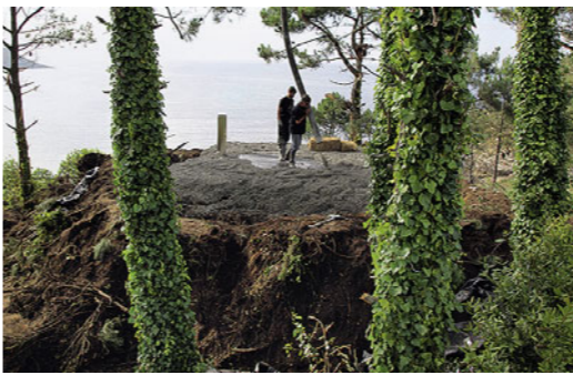
Oberste Zementschicht als Dach
