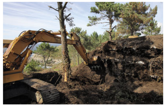
Der Erdwall wird weggebaggert
