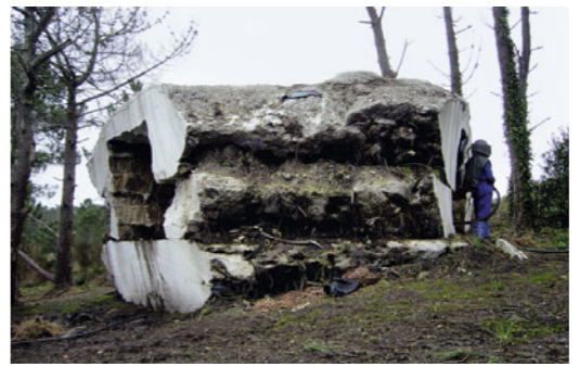
Hütte mit Hohlraum vor dem Innenausbau
