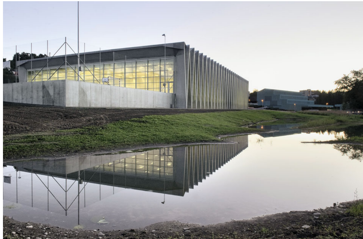
Die Lage der Halle an dem zur Aare hin abfallenden Gelände machte seitliche Plattformen notwendig. Auf der Ostseite ist diese Plattform besonders ausgeprägt. Sie kaschiert das eingegrabene Sockelgeschoss und dient gleichzeitig als Außensportbereich.
