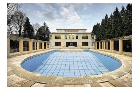
Weiter Blick von der Halle über die „Schranke“ hinweg bis in den Garten mit der Pergola. Die Glasdecke des Salons wird detailliert auf Seite 42 vorgestellt. Das Schwimmbaden wurde ebenfalls vollständig saniert. Ursprünglich war hier ein Erweiterungsbau der Stiftung geplant.
