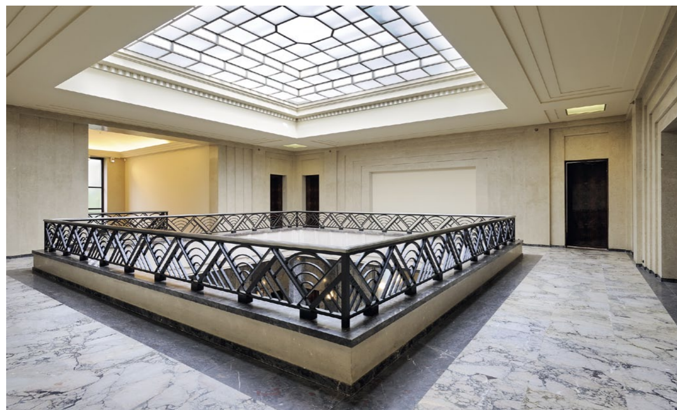
Der sehr breite Umgang im Obergeschoss der zentralen Halle. Rechts der Zugang zu den Schlafzimmern. Vor der Sanierung war das Glasdach durch eine Decke geschlossen worden, um im Dachgeschoss mehr Raum zu haben.
