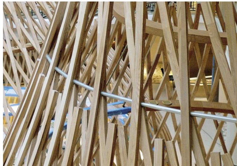
Die Bulles sind durch nur einen Ring im oberen Drittel der Freiformen ausgesteift.
