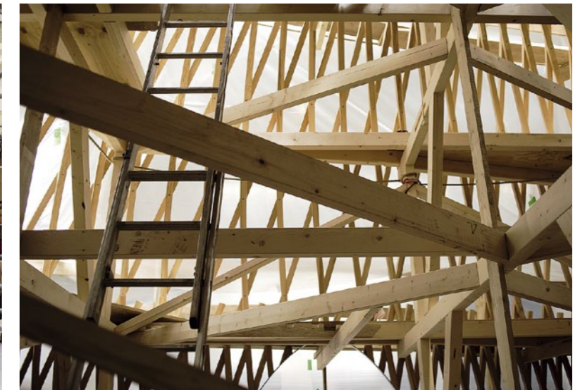
Unten: Auf dem Lehrgerüst, welches im Bau als Tragwerk dient, werden die endgültigen Stäbe in Lagen verleimt.
