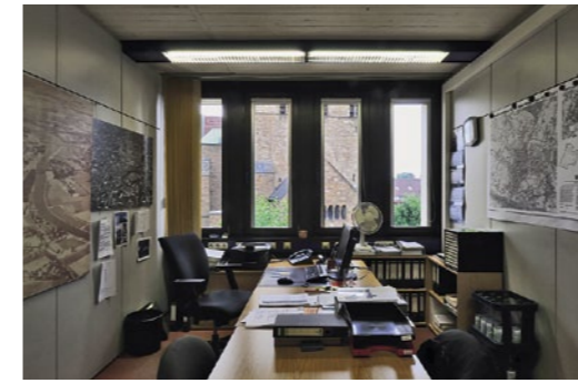
Das enge Achsmaß der Fassade verbaut die gängigen Wege der energetischen Sanierung; eine 20 cm starke Wärmedämmung ließe kaum noch Fensterfläche übrig.
