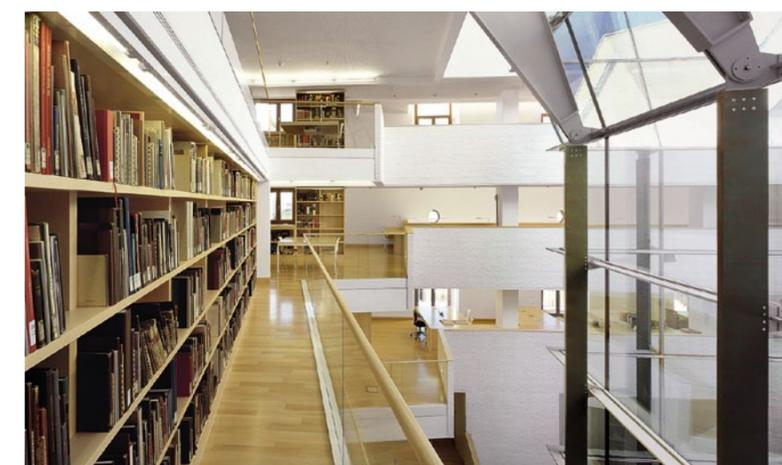
Stahlkonstruktion des gläsernen Innenhofs, der sich trichterförmig aufweitet. Die Ebenen mit den Arbeitsplätzen reichen bis an die alte Fassade
