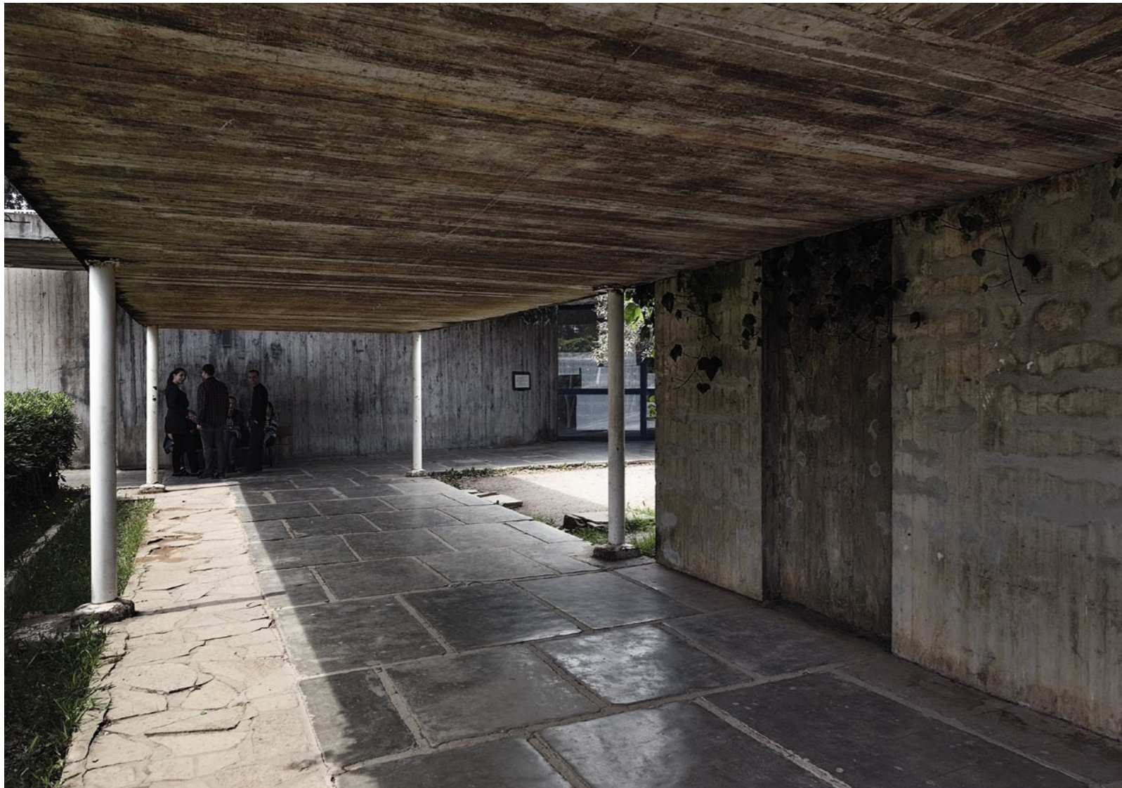
Die leichten, abgehängten Betondächer erhielten nachträglich Stützen. Zeichensaal im 1978 errichteten Neubau. In der Entwurfsaufgabe im April suchten die Studenten nach neuen Nutzungen für Teile des alten Hafens von Algier.
