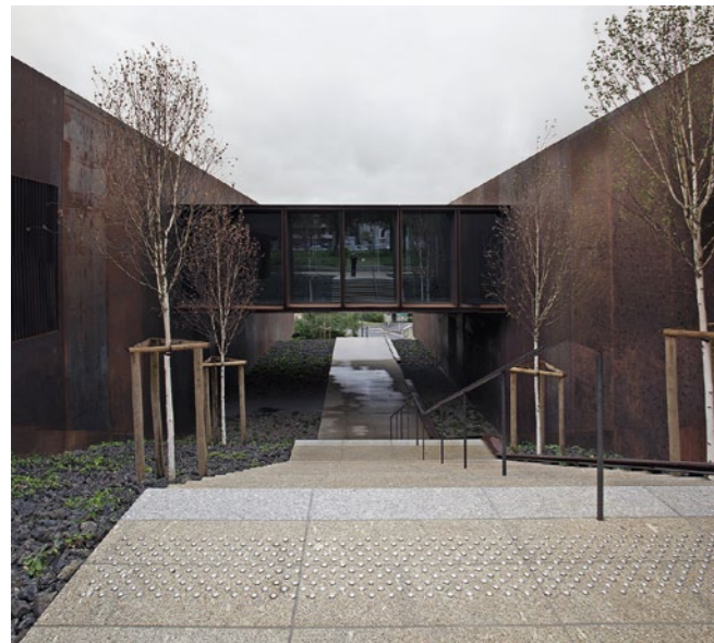
An der Hangkante oberhalb der verkehrsreichen D67 gelegen, dient der Bau auch der Arrondierung des Parks. Die „Boxen“ erzeugen einen Rhythmus aus Tages- und Kunstlichtsälen. Rechts oben: Glasfassade der Dauerausstellung
