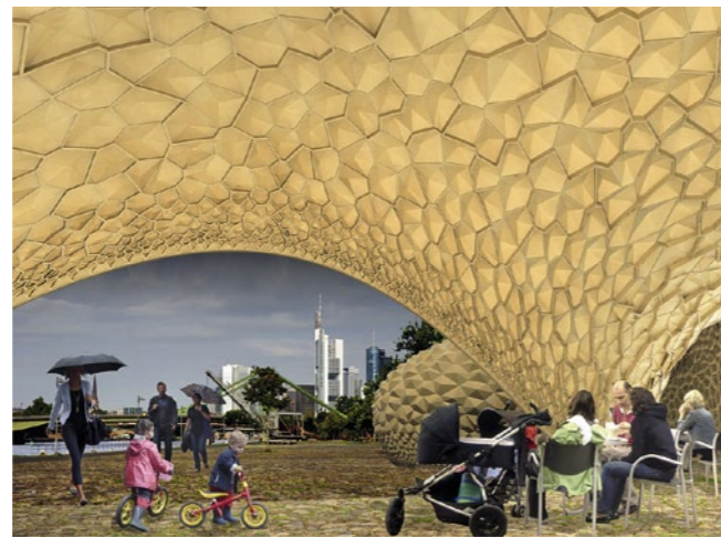
Responsive Surface Structure | funktioniert wie ein Fichtenzapfen: Das reaktionsfähige Oberflächentragwerk (u.) öffnet und schließt sich selbstständig, je nach Grad der Luftfeuchtigkeit. Links: Geplanter Pavillon für die FAZ, Frankfurt
