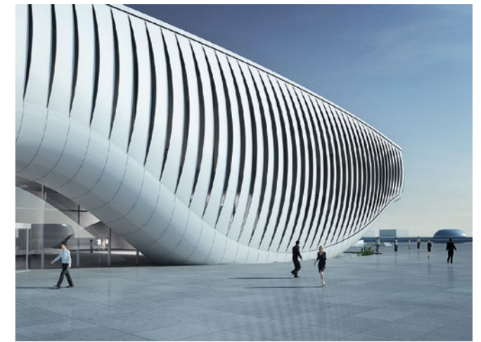
Für den Themenpavillon der EXPO 2012 kommt ein durch Flectofin inspiriertes Lamellen-System zum Einsatz.
