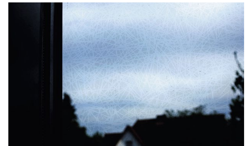
Ornilux-Glas | ist nach dem Prinzip von Spinnennetzen mit UV-Licht reflektierenden Mustern bedruckt, das Vögel sehen, Menschen aber nicht.
