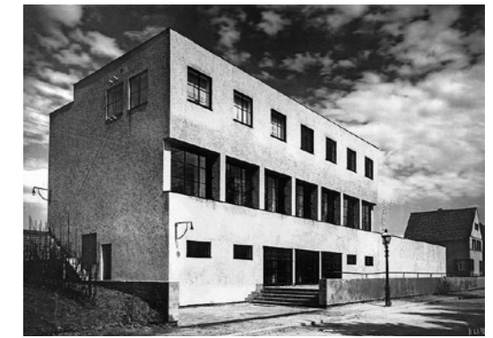
Historisches Foto vom Haus der Jugend mit der ursprünglichen Eingangssituation und der direkt anschließenden straßenbegleitenden Böschungswand
