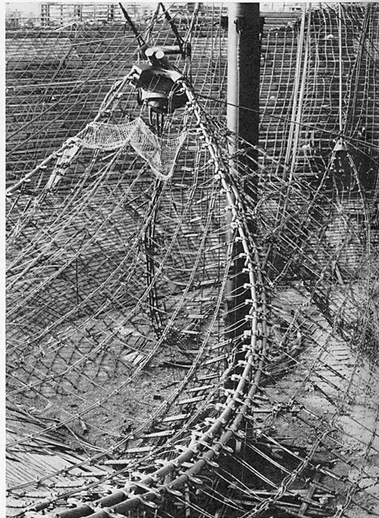
Seilnetz mit Lage der Spannschlösser und Anschluß an Netzgirlandenseil und Augennetzgirlandenseil
