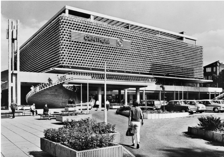
Suhl Dem ehemaligen Centrum-Warenhaus droht der Abriss
