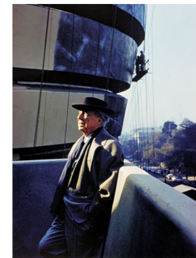
Frank Lloyd Wright, etwa Anfang 1959, auf der Baustelle des Guggenheim-Museums. Foto: William Short © The Solomon R. Guggenheim Foundation, New York
