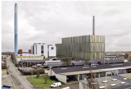
Holm & Grut Architekten unterteilen das abgetreppte Grundvolumen oberhalb eines Betonsockels in drei horizontale Bereiche und geben ihm so mit minimalen Mitteln eine klare architektonische Form. Vertikale Fassadenelemente aus Glas, Kupfer und verschieden perforiertem Aluminium strukturieren die Fassadenbänder. Abbildungen: Architekten
