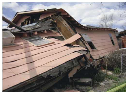
Viele der einfachen Holzhäuser wurden vom Wirbelsturm zerdrückt, zusammengefaltet und fortgespült. Andere, vielleicht etwas solider konstruiert, blieben zwar stehen, sind aber auch unbewohnbar geworden.
