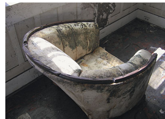
In dem feuchtheißen Klima Louisianas verschimmeln die Polstermöbel und Wandverkleidungen bei eingedrückten Fenstern und offen stehenden Türen schnell.
