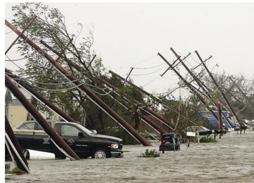
Von Hurrikan Katrina geknickte Strommasten Foto links: Reuters
