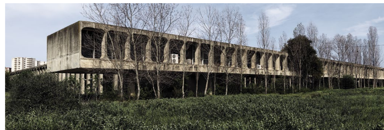
Der schmale, aufgeständerte Verbindungsbau der sieben Gebäuderiegel für die verschiedenen Fakultäten
