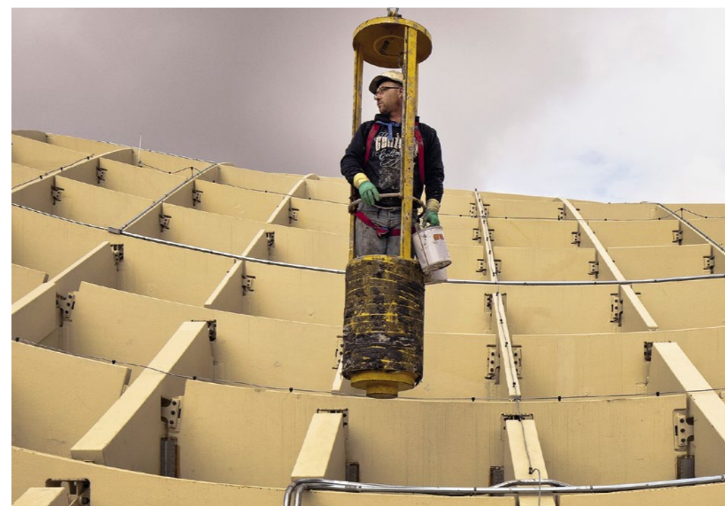
Bei der Montage kamen spezielle Körbe zum Einsatz
