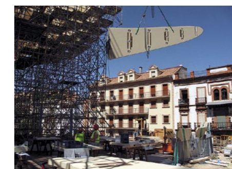
Montage auf der Baustelle
