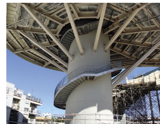
6 Anschluss der Druckdiagonalen mit Hilfe einer Zahnleiste
