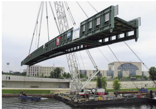
Die Gustav-Heinemann-Brücke wird an den zu überwindenden Spreeabschnitt zwischen Regierungsviertel und Hauptbahnhof gehoben. Die Plattenbalkenbrücke aus zwei seitlichen Vierendeel-Hauptträgern (Baujahr 2005) ist ein Berliner Gemeinschaftswerk von Max Dudler, Frankenstein & Rostalski-Franz-Gräter und KWL Ingenieure.
