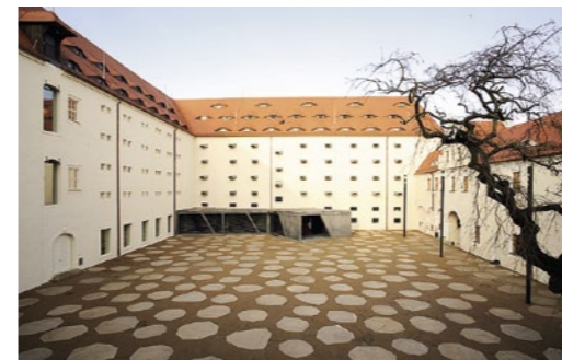
Die Umgebung von Schloss Freudenstein in Freiberg (Bauwelt 12.05) hat Birgit Hammer in Anlehnung an dessen Nutzung als Bergbaumuseum gestaltet. Granitplatten in Gussasphalt bilden im großen Hof Kristalle nach. Foto: Birgit Hammer Landschafts.Architektur
