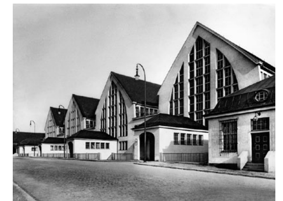
Die Großmarkthalle im Jahr 2011 und zur Eröffnung 1912 (Innenraum 1915)
