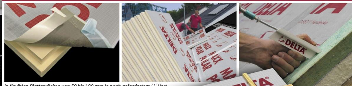
In flexiblen Plattendicken von 50 bis 180 mm je nach gefordertem U-Wert
