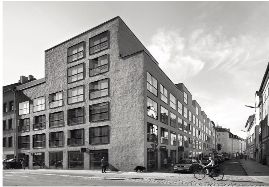
▲ Landsberger Straße | Den dunkelroten Wohnblock von Fink und Jocher bemerkt man nicht gleich. Farbe und Tektonik sind aus dem Bestand abgeleitet. Die Lärmimmissionen waren der Grund für die wunderschöne, kinetische Schallschutz-Fassade | Rainer Hofmann
