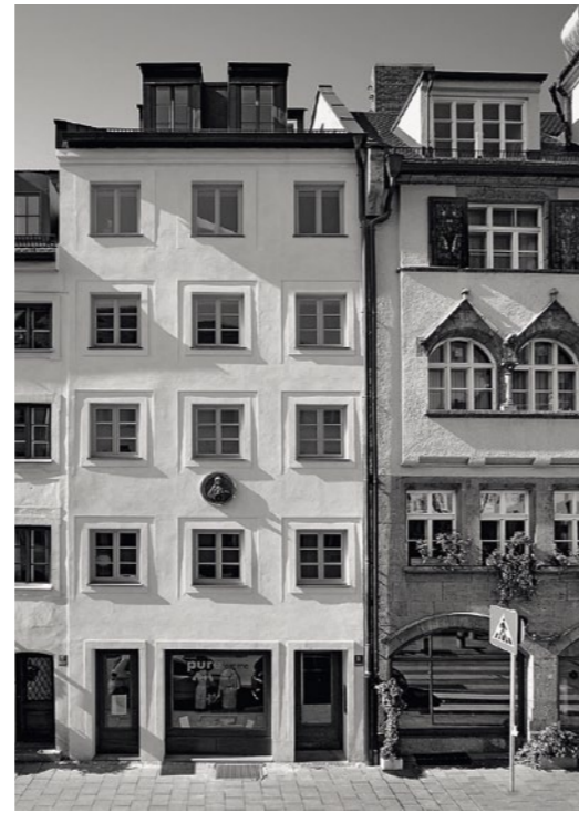
▶ Brunnsstraße | Der erste Blick auf das von Andreas Hild sanierte spätbarocke Handwerkerhaus hinterlässt eine Irritation zwischen dem was man kennt und dem was man sieht: eine Fassade, die durch das Schattenspiel in Bewegung gerät, eine Fassade mit zwinkerndem Blick | Andreas Gierer
