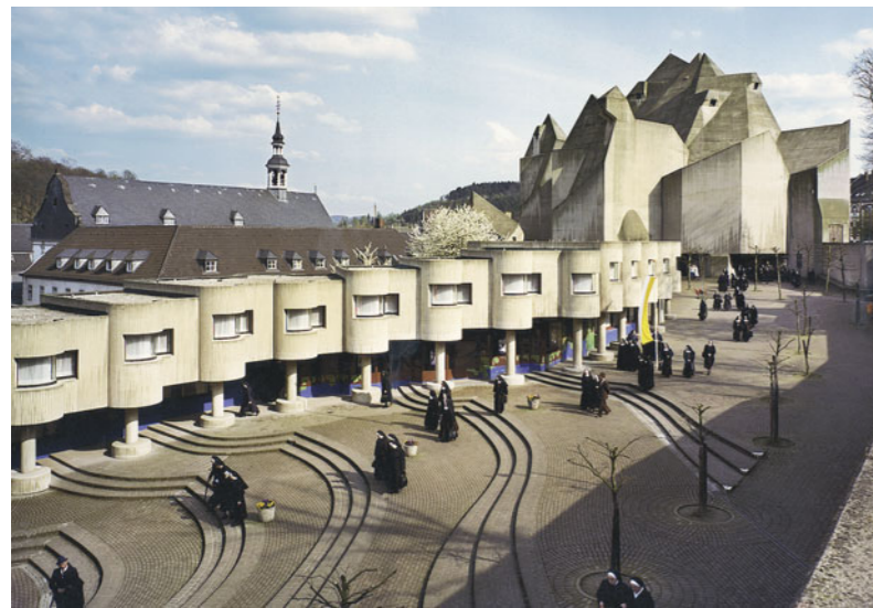
Kohleskizze und fertiges Bauwerk: Wallfahrtskirche Maria Königin des Friedens in Velbert-Nevigis, 1963–68. Unten rechts: Züblin Verwaltungsgebäude in Stuttgart-Vaihingen, 1981–85, fotografiert von Karl Hugo Schmölz. Fotos: Inge und Arved von der Ropp (links), Rheinisches Bildarchiv; Zeichnung: DAM, Archiv
