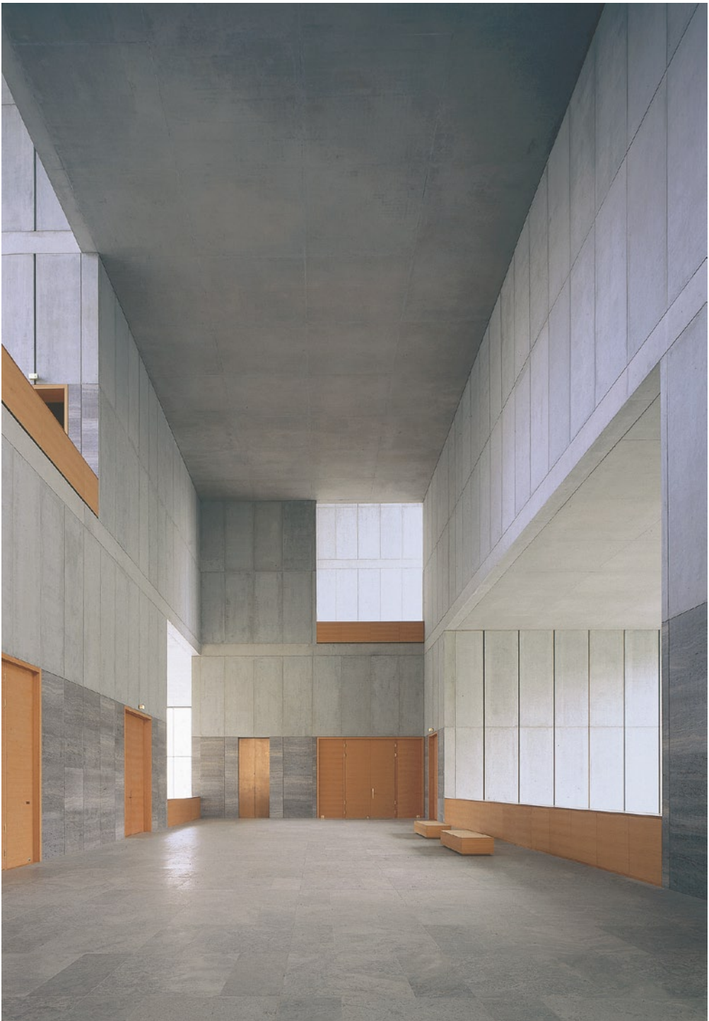
Die zentrale Halle im ersten Obergeschoss: Der schlichte Kalkstein mit seiner kontrastarmen Struktur stellt den Sichtbeton nicht in den Schatten, sondern nähert sich vielmehr dessen Oberfläche an und belebt sie.
