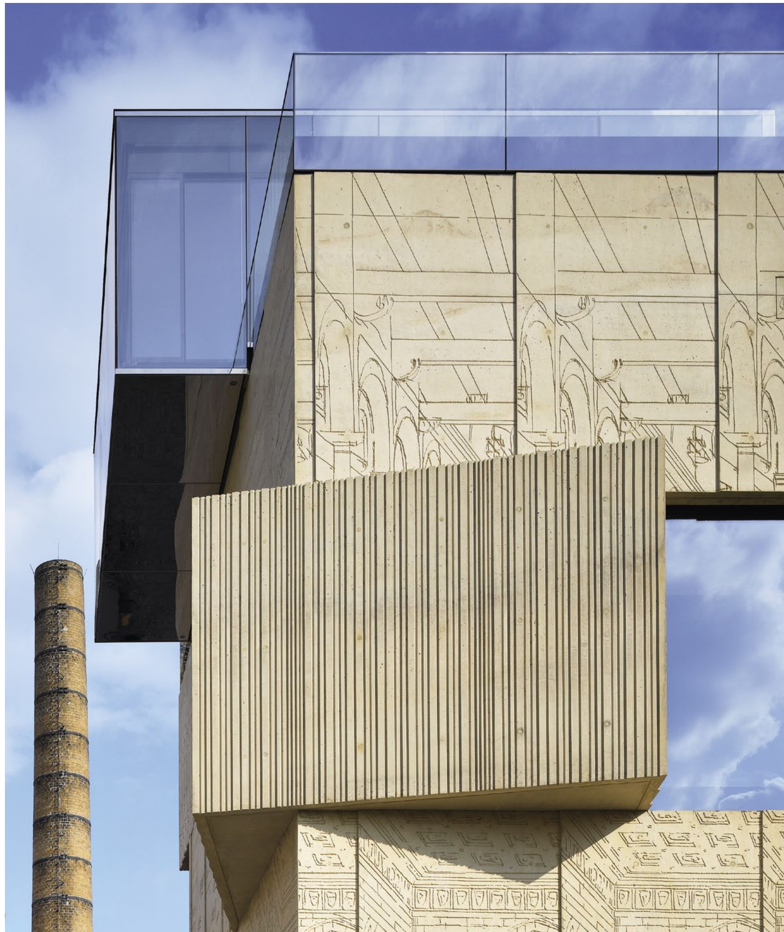
Detail der Fassade am Teutoburger Platz
