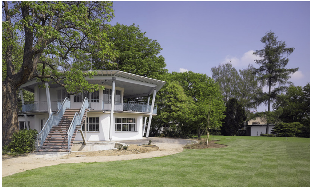
Der Restaurant-Pavillon erhielt im Rahmen der Sanierung seine ursprüngliche Farbfassung zurück. Einst war das Gelände am Letziggraben die Hinrichtungsstätte von Zürich. Max Frisch platzierte den achteckigen Holz-Pavillon exakt am ehemaligen Standort des Galgens – Ausdruck einer ironisch-morbiden Ader des Schriftstellers Frisch?
