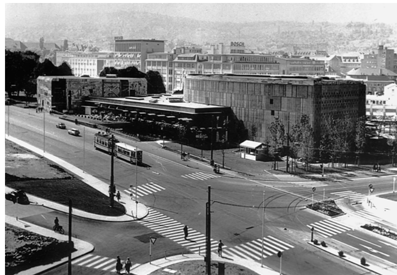
Am 21. Juli 1956 wurde die neue Stuttgarter Liederhalle eröffnet – damals ein Solitär am Rande der Innenstadt. Unten der Blick in den noch offenen Bühnengraben des großen Saals während des Richtfests.
