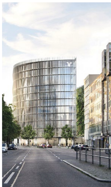
1. Preis | Barkow Leibingers Vorschlag für den Neubau der Volksbank von der Nürnberger Straße gen Norden geschaut. Unten: Blick gen Osten im Oktober 2011
