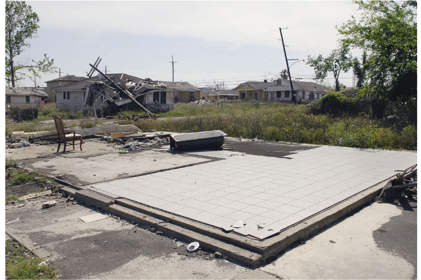
Im Lower Ninth Ward, dem Symbolquartier für den Untergang, hat Hurrikan Katrina das Haus umgeworfen, die Flut hat es danach weggespült. Was bleibt, ist die Bodenplatte ohne Fundament, die für den Wiederaufbau nicht taugt, und ein leerer Stuhl, der irgendwann später abgestellt wurde. Ein Polizist, der im Lower Ninth Ward patrouillierte, stellte uns zur Rede, als wir fotografierten. „You can proceed, but do not enter the houses. We still find dead bodies.“
