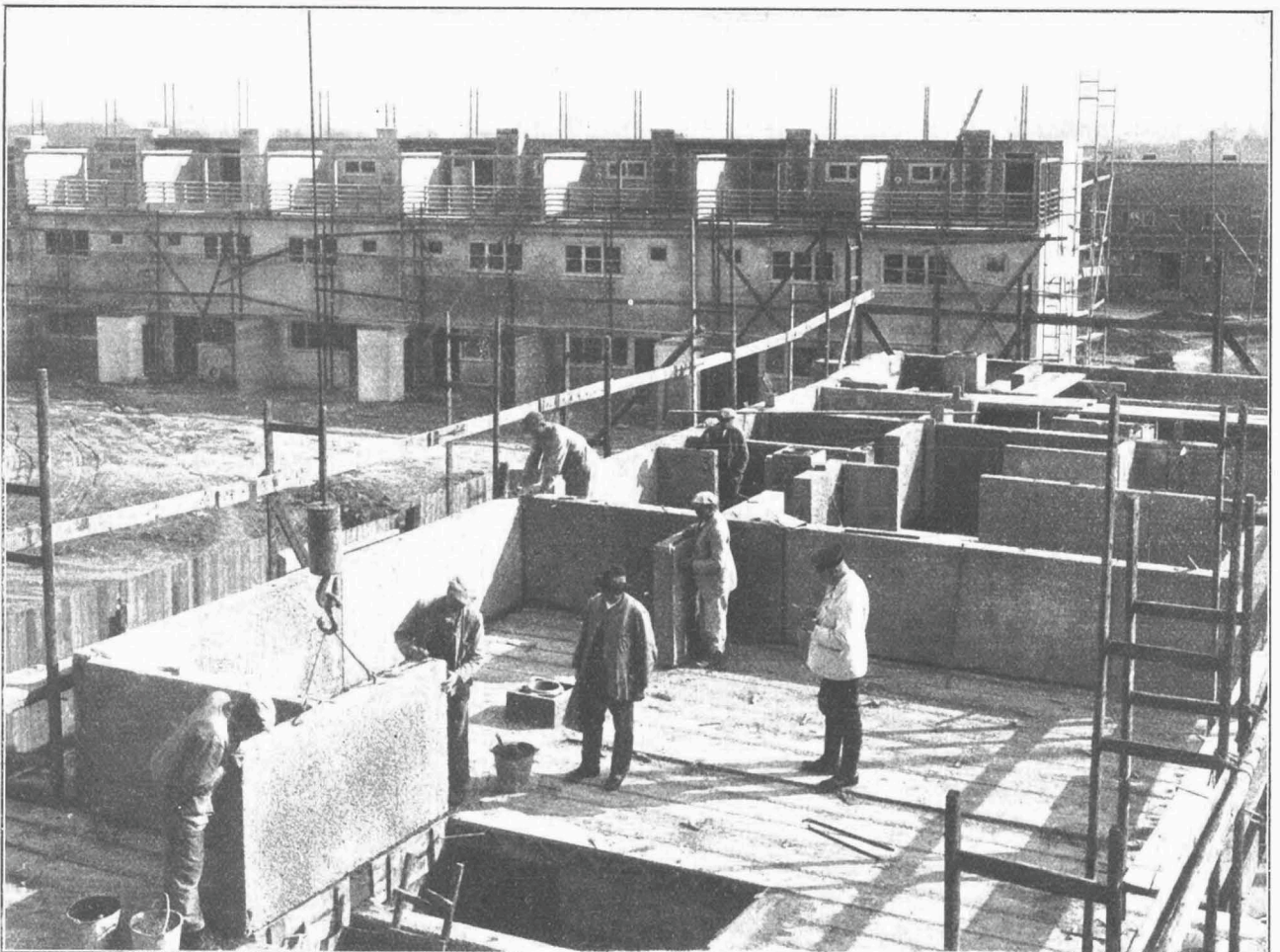
Abb. 13. Die Montage im Betrieb. Im Hintergrund die bereits fertiggestellte erste Häuserreihe
