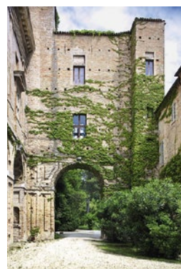
Innenhof der Kastellvilla, auch Sforza-Villa genannt. Darunter: der Durchgang zwischen der alten Villa und der Fassadenwand der Hochrenaissance. Im Obergeschoss verbirgt sich ein Hochkorridor.
