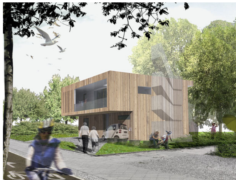
3. Preis | Das Team von der UdK Berlin schlägt einen kubischen Baukörper vor, der die E-Mobile durch das überkragende Obergeschoss überdacht und in Szene setzt. Das Haus ist aus Holz und soll weitgehend vorgefertigt werden. Die fast vollständig geschlossene Südfassade irritierte die Jury. Grundrisse im Maßstab 1:333; alle Abbildungen: Planer
