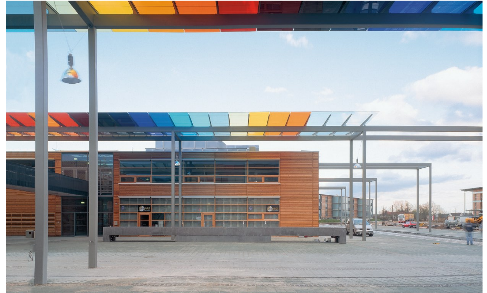
Auf dem „Marktplatz“ wurde bei den Glasdächern ein Farbkonzept des Salzburger Künstlers Josef Schwaiger umgesetzt. Das Spektrum umfasst 13 Farben, die durch Schichtung von unterschiedlichen Farbfolien zwischen den Glasscheiben entstehen. Damit soll im Zentrum der SolarCity die sinnliche Qualität des Sonnenlichts hervorgehoben werden. Im Norden öffnen sich die „Gassen“ zu den niedrigen, provisorisch wirkenden Wohnhausbändern von Richard Rogers (folgende Seiten), die sich nur schwer in das städtebauliche Gesamtkonzept eingliedern.
