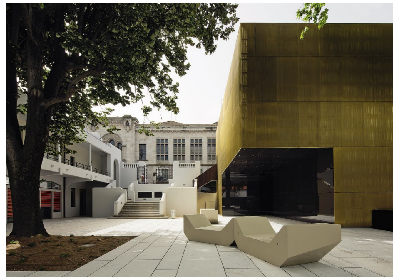
Blick auf die historische Treppenanlage, die zur Rua Paio Galvão führt. Das historische Gebäude auf der linken Seite, vom Architekten José Marques da Silva (1869–1947), wurde renoviert.
