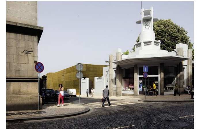
Der ehemalige Marktplatz liegt unmittelbar nördlich der Altstadt. Oben der Zugang an der Rua Paio Galvão
