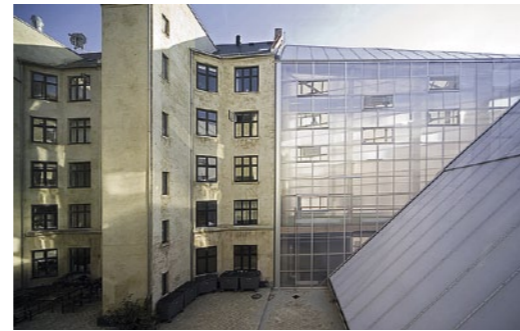
„Bauen muss billiger werden“: Arno Brandhubers Sporthalle in Kopenhagen. Sparen beim Aufwand für die Fassade ermöglichte ein insgesamt größeres Raumvolumen.
