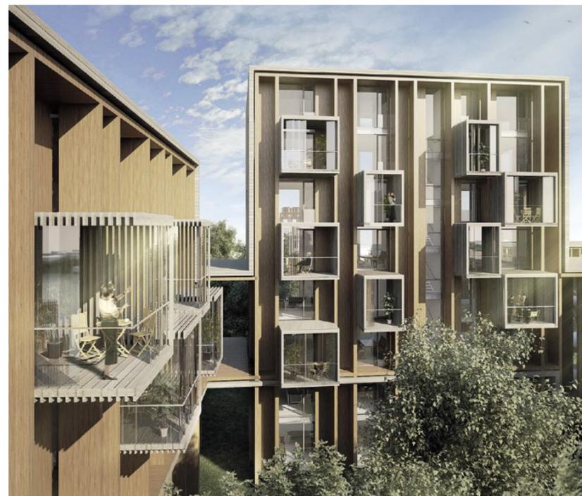
ein 1. Preis | Die Grundlage des Vorschlags „E2volution“ vom Team um Arup bildet das von Finnforest Merk hergestellte Kerto-Furnierschichtholz. Mit drei Typen von tragenden Elementen, u. a. Hohlkastenplatten, können zehn Meter überspannt und eine Vielfalt an Grundrissen erzeugt werden. Acht Geschosse sind möglich. Die Jury lobte die Klarheit der Konstruktion, sah aber Defizite im Städtebau und bei der Ausrichtung der Wohnungen.
