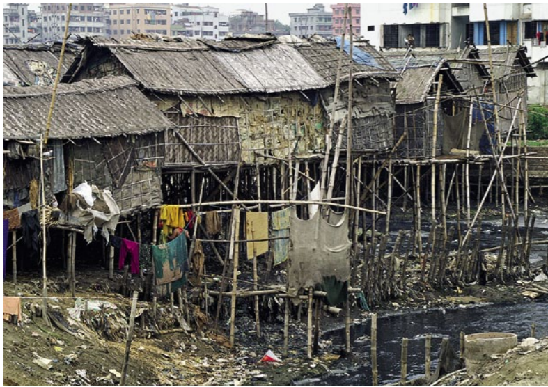
Wohnen am Wasser: Pfahlbauten am Buriganga auf Schutt und Müll und neue Wohnanlagen für die Mittelschicht am
