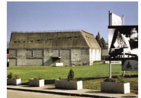
Die Skizze der Kirche entstand zwei Jahre vor dem Tod von Le Corbusier. Das Holzmodell, es entspricht exakt dem Entwurf, steht vor dem Beton-Rohbau in Firminy-Vert, der wie ein verlassener Bunker erscheint.
