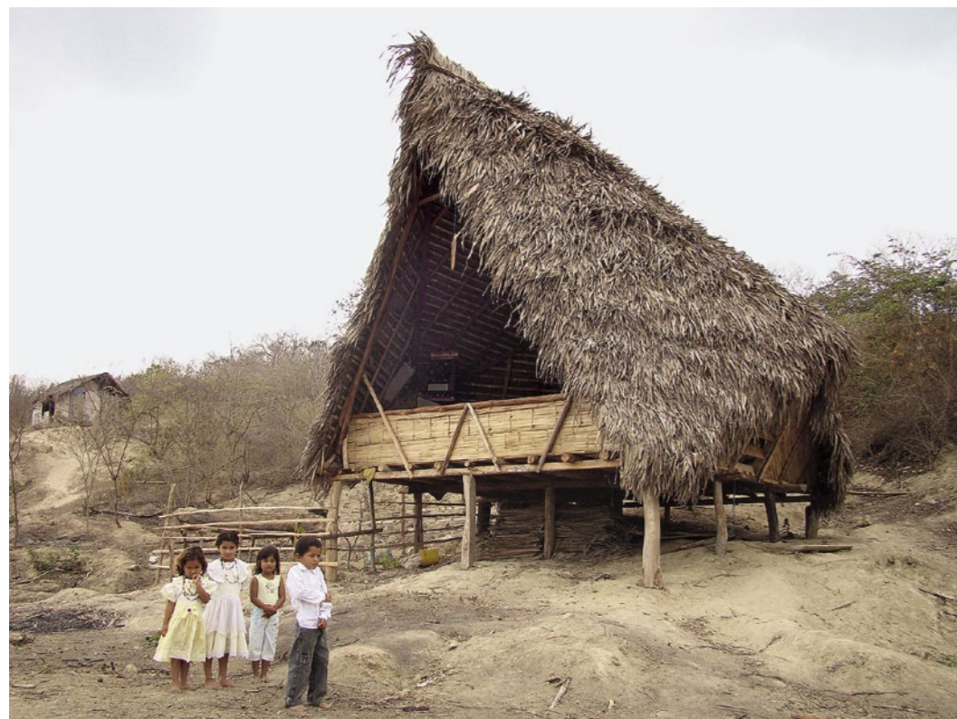
Die Schule Nueva Esperanza, deren Form an ein Boot erinnern soll, liegt im Dorf El Cabuyal an der ecuadorianischen Küste. Al Borde bauten sie im Jahr 2009 für 200 Dollar so, wie die meisten Bauten der Umgebung: mit Holzfundament, Wänden aus Bambus und einem Dach aus Stroh. Weitere Schulen sollen folgen.
