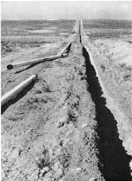
Bau einer Rohrleitung im Negew
