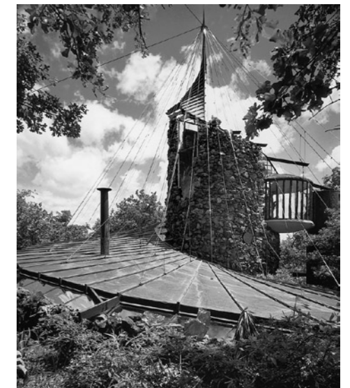
Eugene Bavinger House bei Norman, Oklahoma (1950). Am höchsten Punkt des Hauses liegt das Atelier. Der fließende Raum wird mit einem Fenster bis unter das Dach geführt, wo die Idee der Spirale in der Aufwärtsbewegung der Blechpaneele bis zur Spitze des Masten fortgesetzt wird. nächste Seite: Blick in den Eingangsbereich
