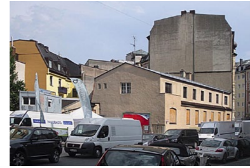
Bauplatz des geplanten KomPro/B Wohnprojektes
