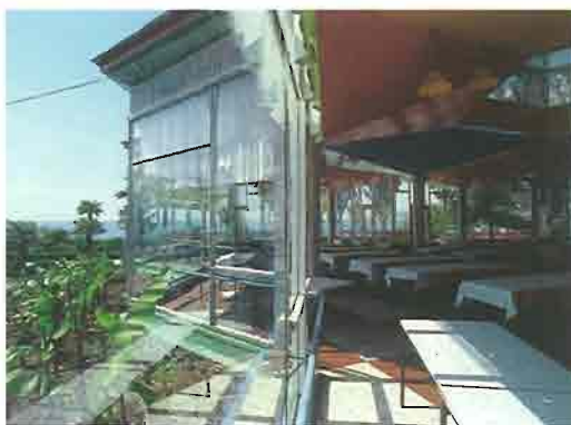
Die Mensa mit den aneinander gesetzten Stahlbeton-Pilzstützen erhielt inzwischen teilweise eine Glasfassade. Pilzstützen fanden auch Verwendung für in der Landschaft eingestreute Sitzgruppen und für Bushaltestellen.
