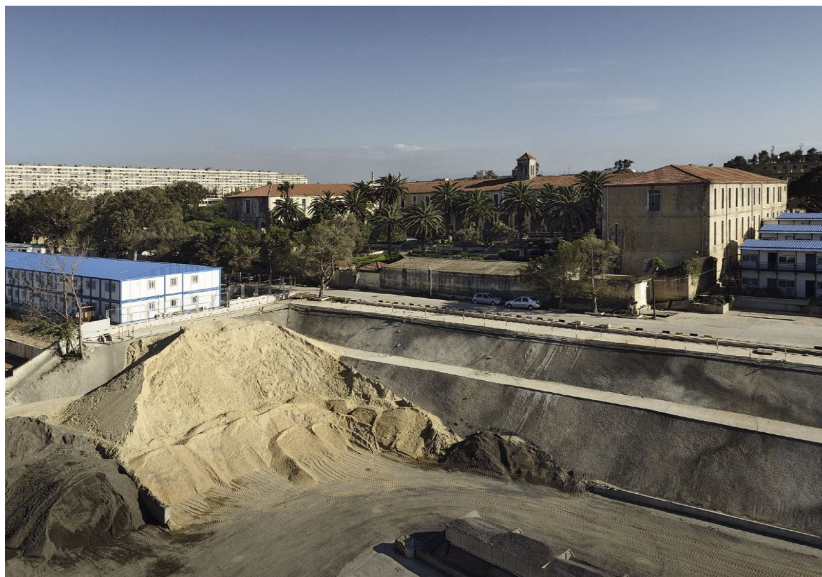
Baustelle mit dem ehemaligen Konvent im Hintergrund
