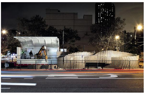
Die Architekten Gramazio & Kohler und ihr Team an der ETH Zürich haben ein Programm entwickelt, das gekrümmte Formen und grafische Elemente auf Mauerwerk überträgt. Lage und Drehung jedes Ziegels kalkuliert der Computer; ein 6-Achs-Roboter, der Spezialklebstoff an den richtigen Stellen anbringt und den Ziegel platziert, führt die Produktion vollautomatisch aus. Für die 7000 Ziegelsteine der Kunstinstallation "Pike Loop" in Manhattan (2009) war er vier Wochen beschäftigt.
