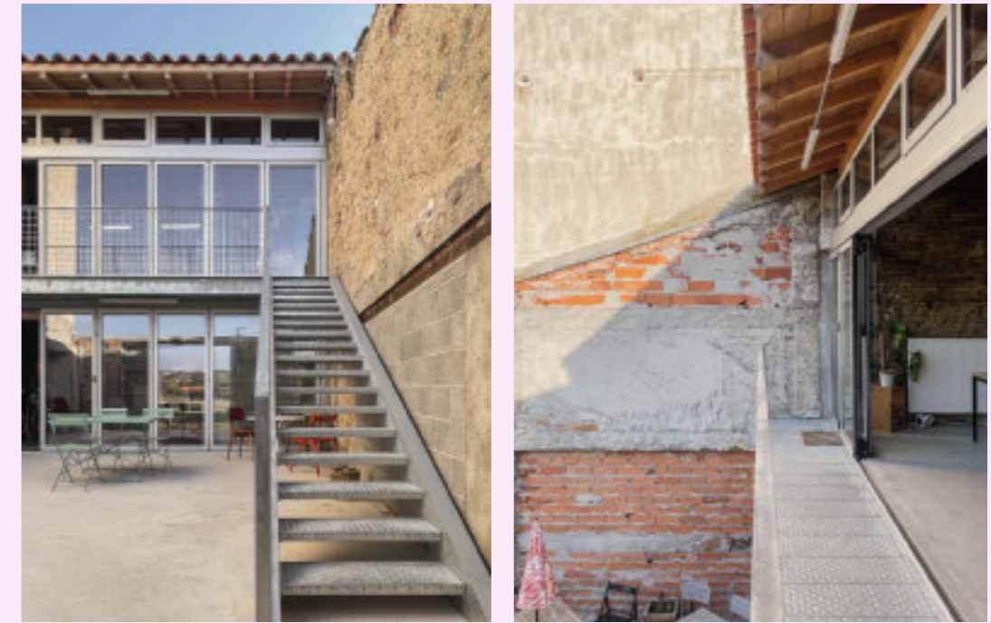
Die Stahlelemente und Aluminiumfensterrahmen heben sich deutlich vom Bestand ab. Fotos: BAST
