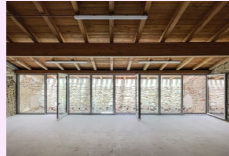
Vollflächige Verglasungen bilden die neuen Fassaden. Auf der Seite zum Canal du Midi schaut man größtenteils gegen die Bestandsmauer, in der eine Eingangstür sitzt. Tageslicht fällt über das Dach ein.
