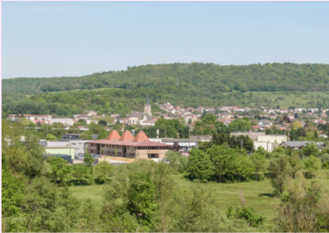
Die drei Dachhauben verleihen dem neuen Gemeindesitz Präsenz in der Wahrnehmung des zerstreuten Siedlungsbilds.
